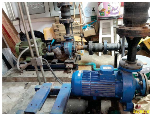
ตู้ควบคุม และเครื่องปั้มน้ำขึ้นใต้ดิน
